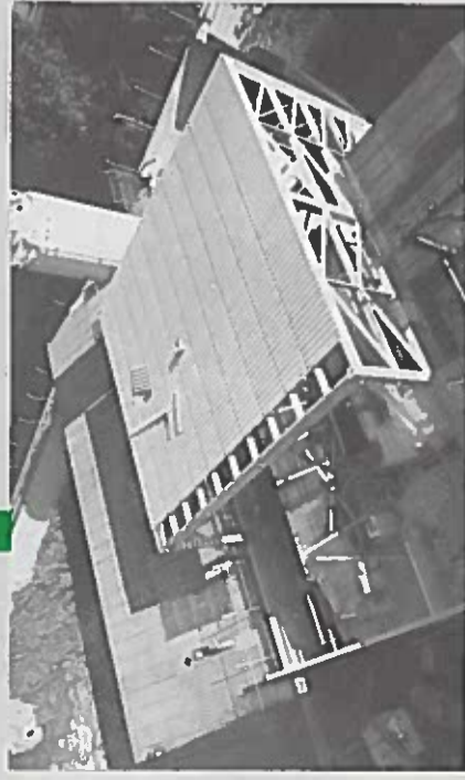
L'étage : sa charpente et sa toiture.
